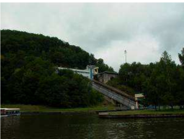
Schiffshebewerk bei Arzviller
