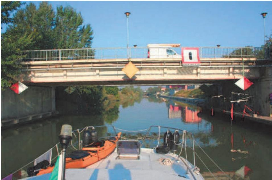
Die sichere Durchfahrts Passage unter einer Brücke wird zusätzlich gelb gekennzeichnet
